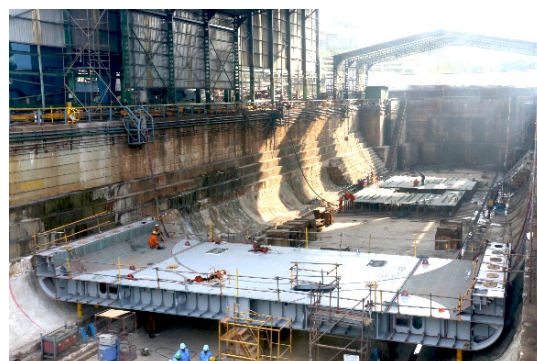
ドックへ移動したブロック同士を溶接し組立
